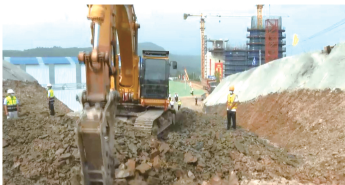
大型机械作业 本组图片 城市晚报全媒体记者 刘佳雪 摄
