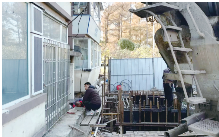
正进行电梯混凝土施工 城市晚报全媒体记者 刘佳雪 摄
