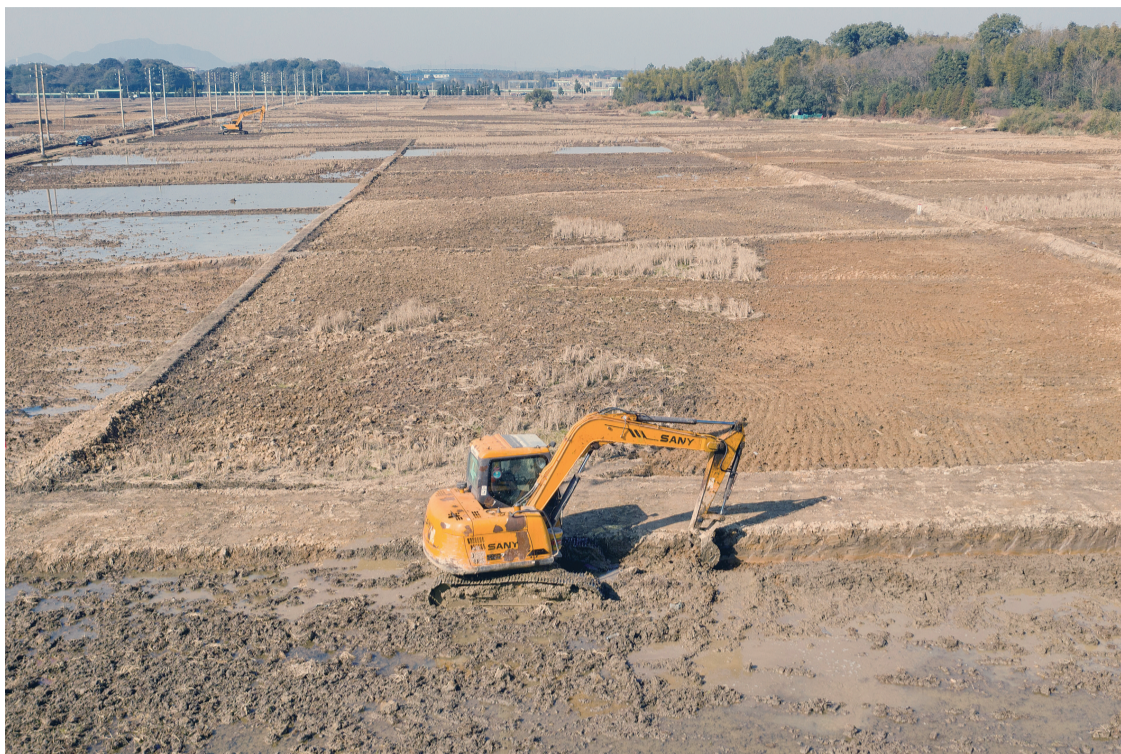
1月29日,在江西省抚州市金溪县秀谷镇五里村高标准农田建设现场,施工人员开动机械设备建设高标准农田。 新华社发 邓兴东 摄
