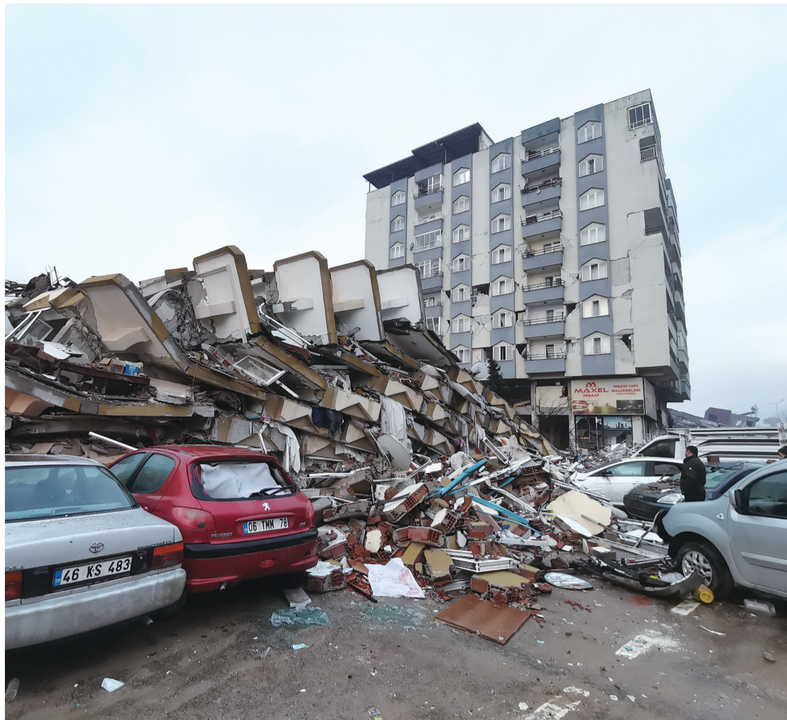
这是2月7日在土耳其卡赫拉曼马拉什拍摄的一处倒塌的建筑(手机照片)。
