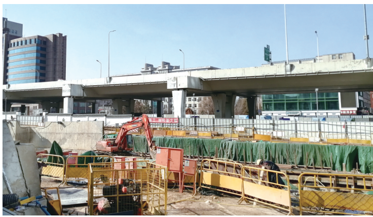
在建轨道交通5号线项目 城市晚报全媒体记者 刘佳雪 摄
