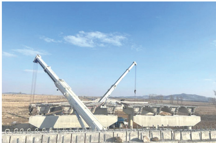
高速公路续建项目复工 省交通运输厅供图
