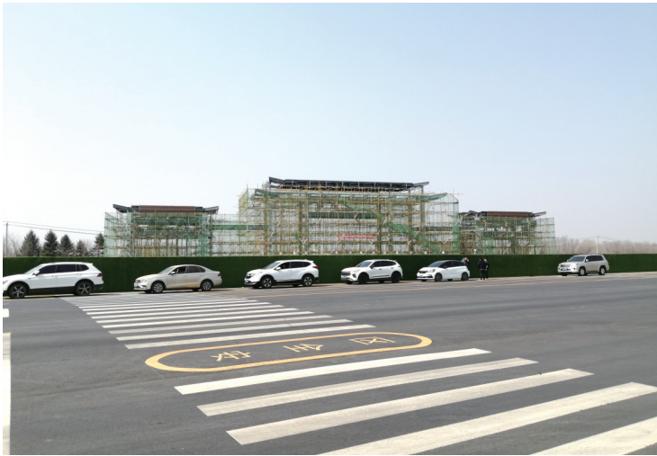
新建的“北湖门”已经完成主体建设 城市晚报全媒体记者 刘佳雪 摄
