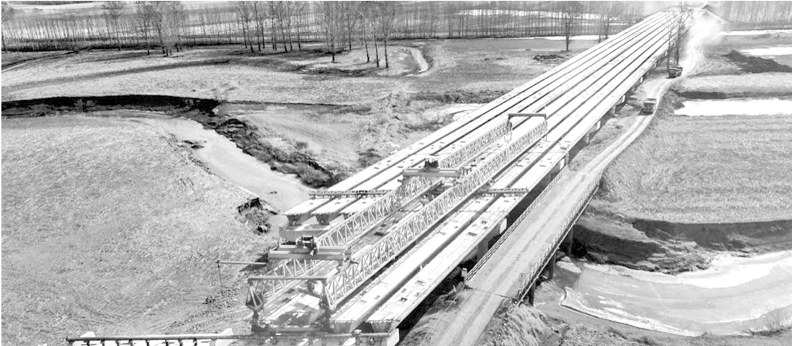
最后一片30米箱梁精准落位 长环高速联合体总项目部供图
