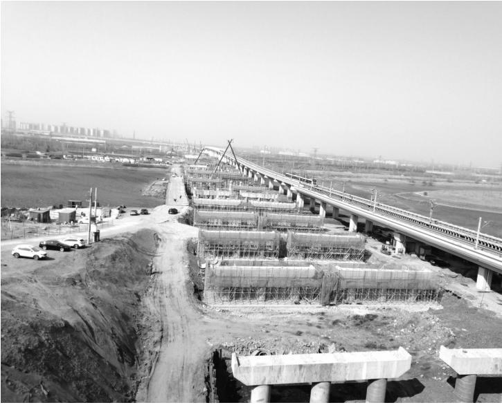
北湖大桥施工现场 城市晚报全媒体记者 刘佳雪 摄
