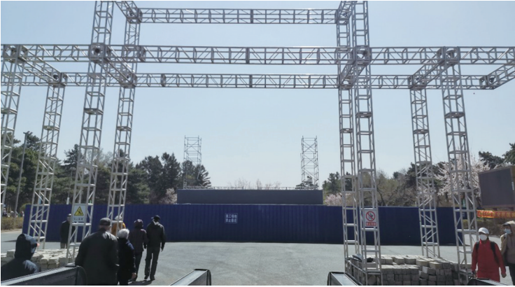
正在施工的不夜街 城市晚报全媒体记者 吕闯 摄
