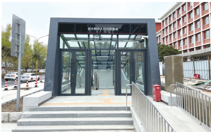
人行过街通道入口 城市晚报全媒体记者 陆续 摄
