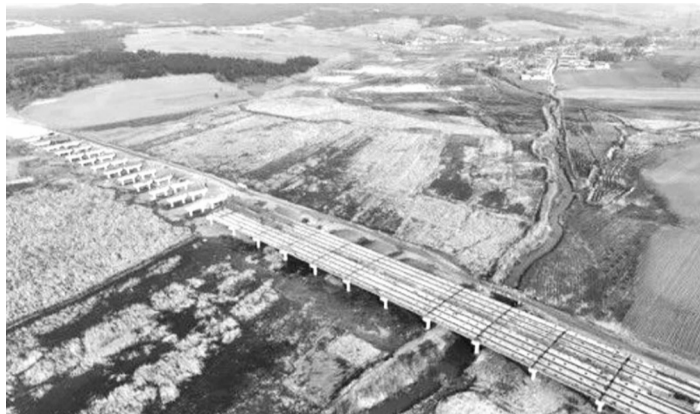
永胜河大桥 长环高速联合体总项目部供图
