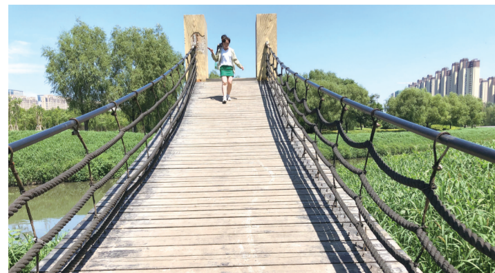
园内人行吊桥
