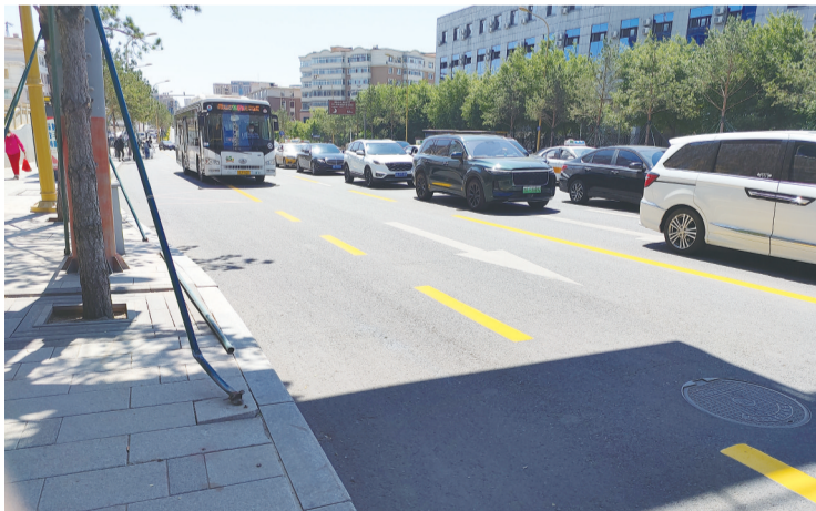
已完工的公交专用道 城市晚报全媒体记者 陆续 摄
