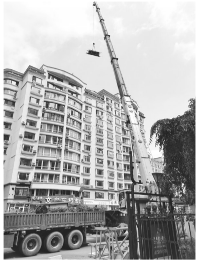
起重机从楼顶吊运建筑材料
