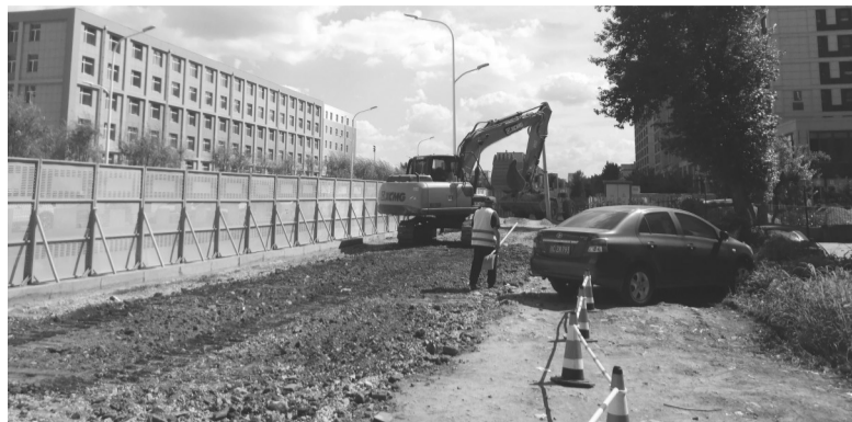
道路升级改造施工现场 城市晚报全媒体记者 刘佳雪 摄
