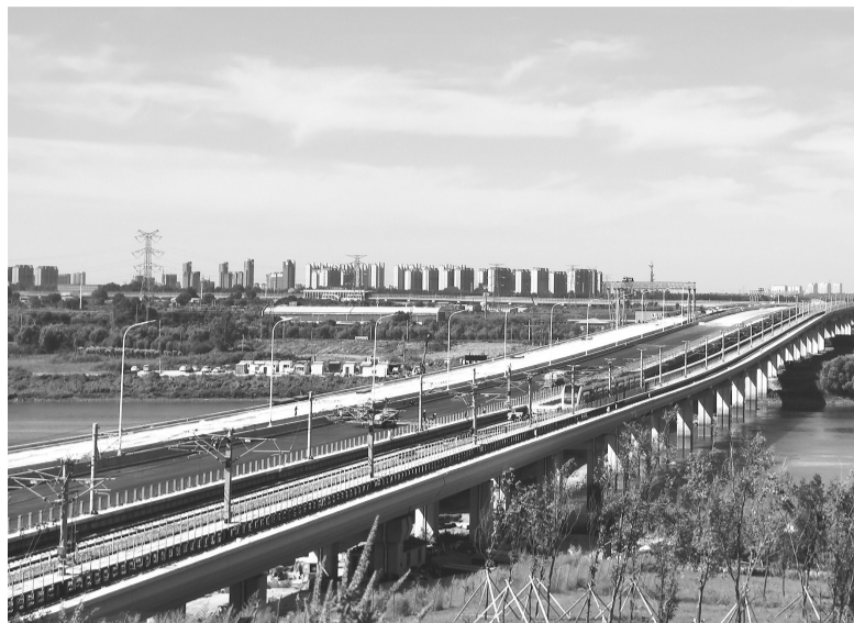
北湖大桥北侧已进行桥面铺设 城市晚报全媒体记者 吕闯 摄
