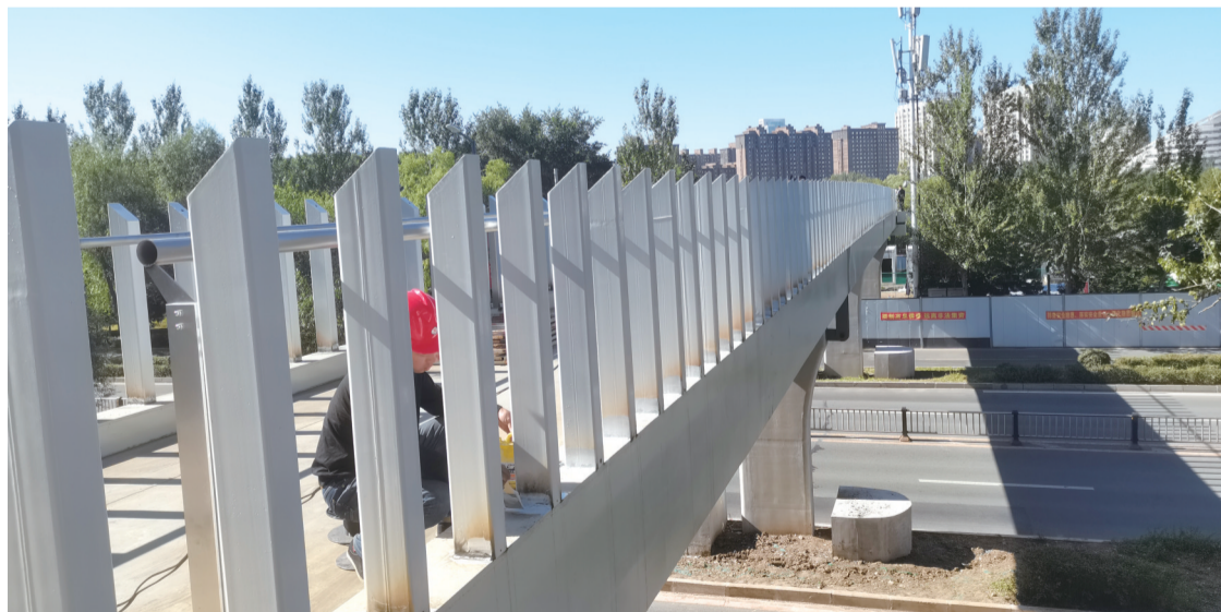
施工工人进行工程收尾工作 城市晚报全媒体记者 陆续 摄
