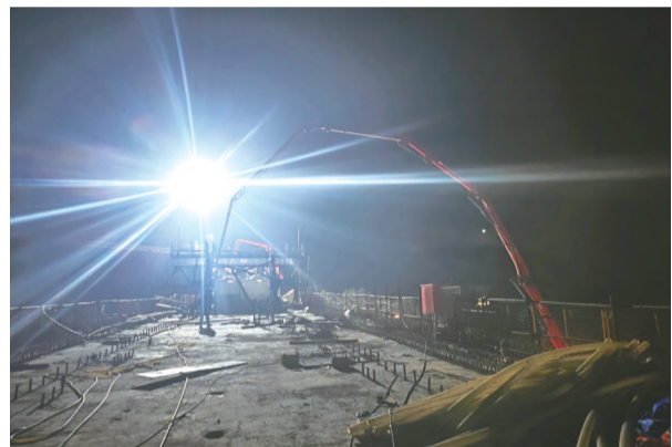
施工现场 项目部供图
