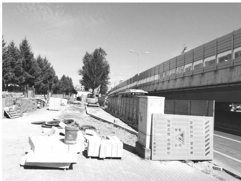
“港湾式”候车站正在施工中 城市晚报全媒体记者 刘佳雪 摄
