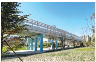
高架桥桥墩被涂上了色彩
