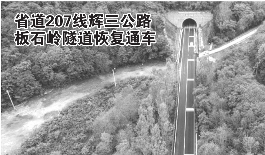
板石岭隧道恢复通车 白山市公路处供图
