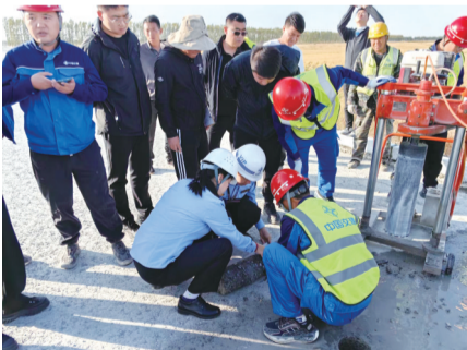
执法人员对环线高速工程质量进行检查
