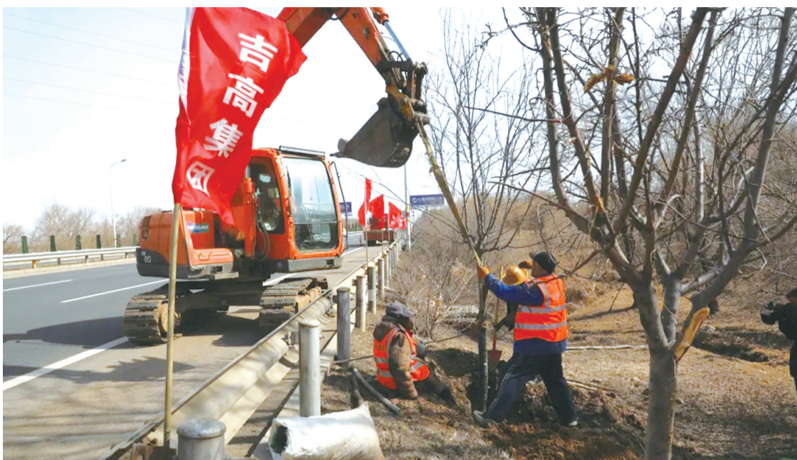
机械吊装树苗 本组图片 省交通宣传中心供图
