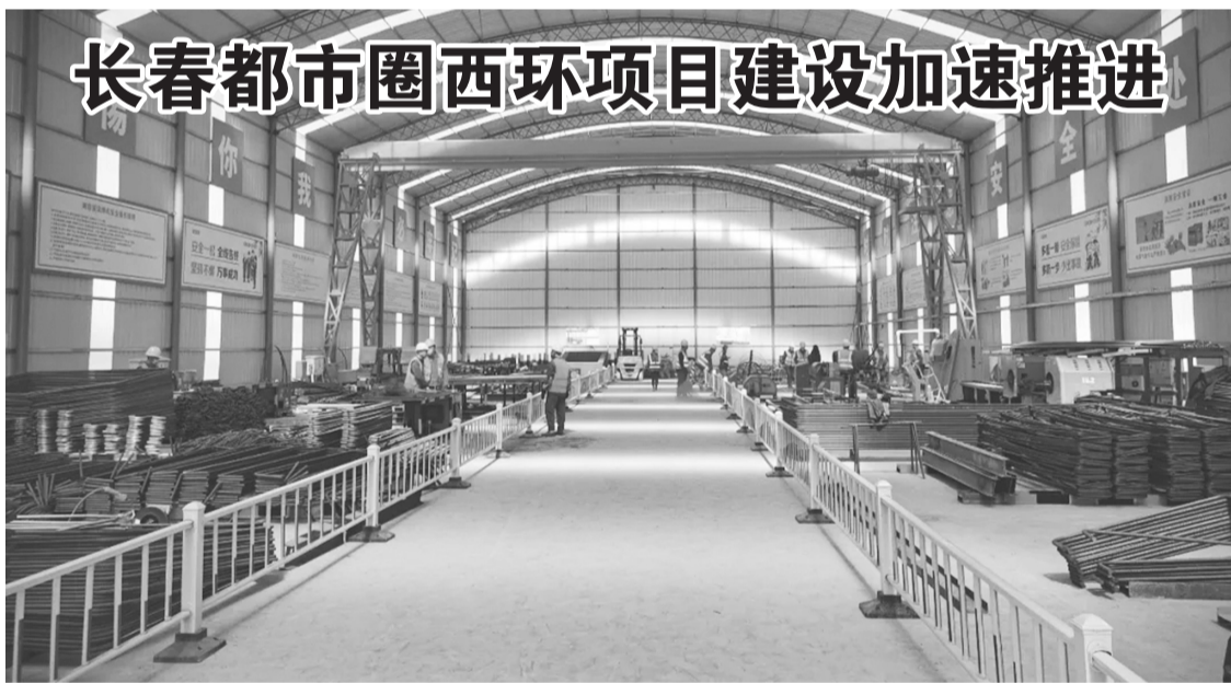
钢筋绑扎作业 吉高集团供图
