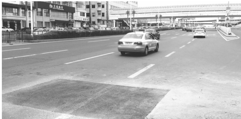
塌陷的路面已经修复完毕 城市晚报全媒体记者 刘佳雪 摄
