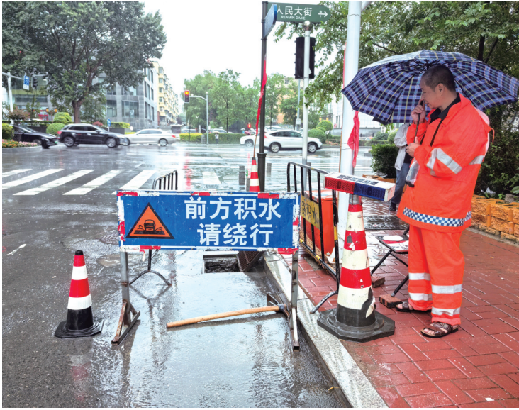
城区防汛人员在积水点值守 本组图片 城市晚报全媒体记者 陆续 摄
