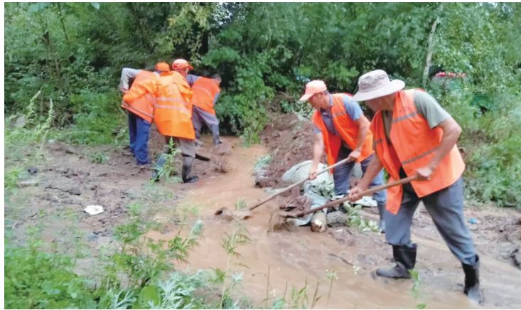
清理公路边沟 省交通运输厅供图
