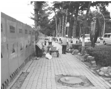
工人正在认真施工
