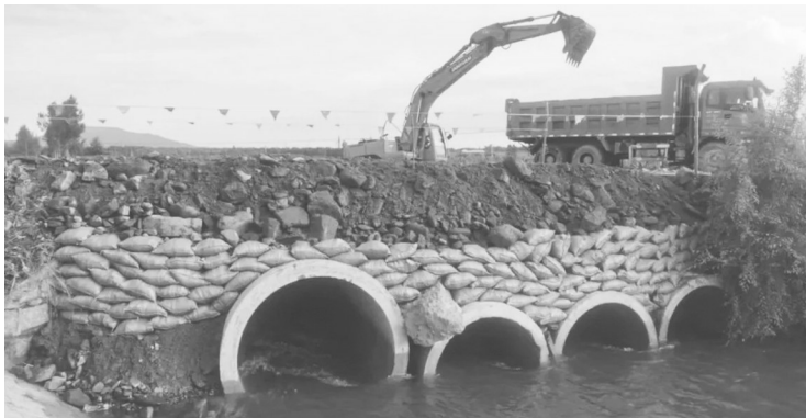
挖掘机抢险作业 省交通运输厅供图
