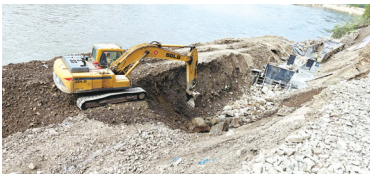
紧张推进建设
