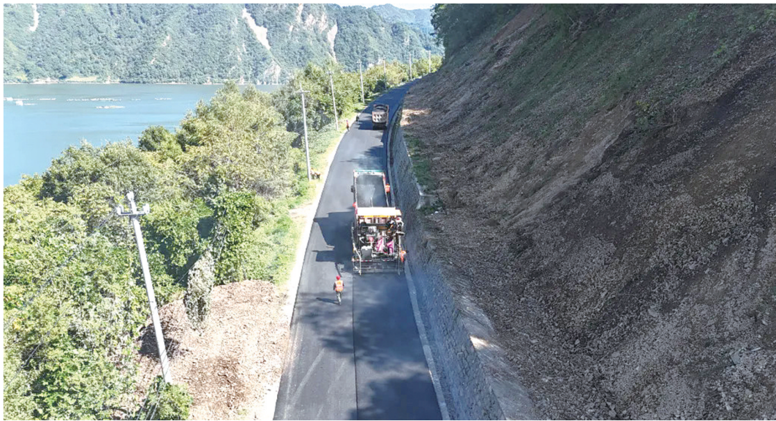
路面铺筑 本组图片 省公路局供图
