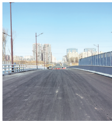
桥面已经完成了沥青铺装
