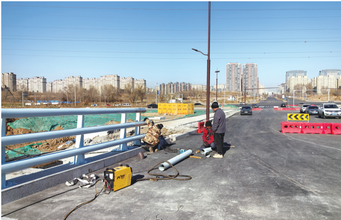
施工工人正在进行收尾工作 本组图片 城市晚报全媒体记者 陆续 摄
