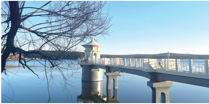
净月潭放水塔 净月潭景区供图
