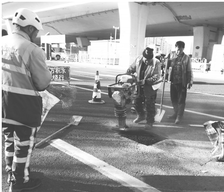
维修施工作业 本组图片 城市晚报全媒体记者 刘佳雪 摄
