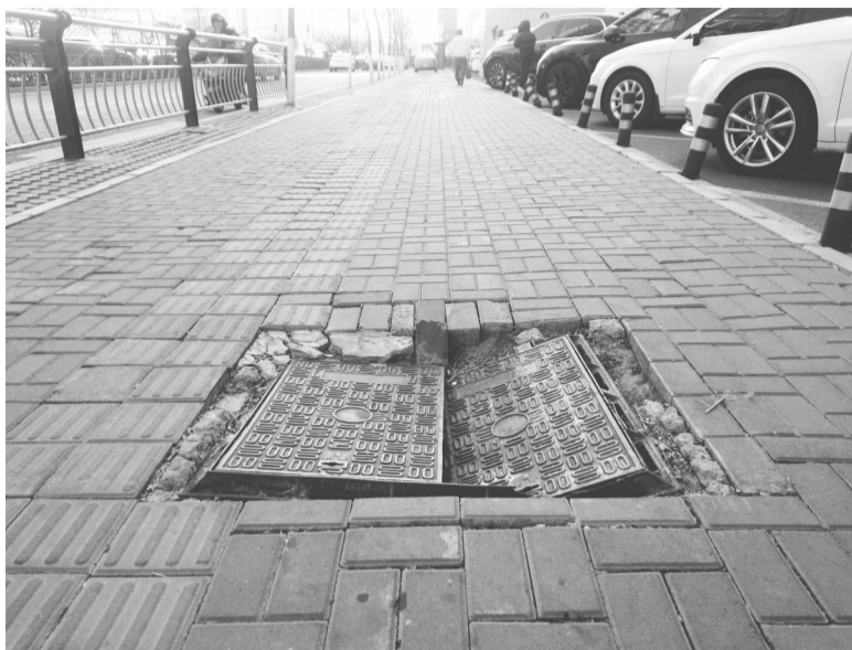
井盖严重塌陷存在安全隐患 本组图片 城市晚报全媒体记者 刘佳雪 摄
