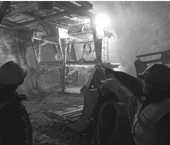
施工现场 省高建局供图
