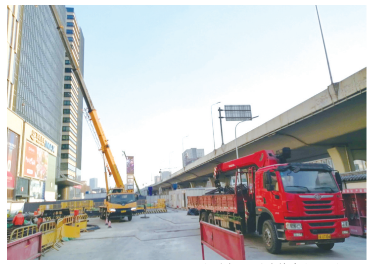
轨道交通5号线繁荣路西站点施工
