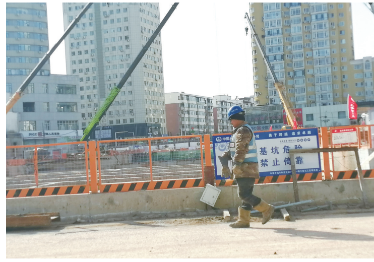
一名施工人在5号线同志街站工地
