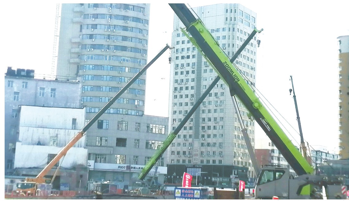
轨道交通5号线同志街站建设工地 本组图片 城市晚报全媒体记者 刘佳雪 摄
