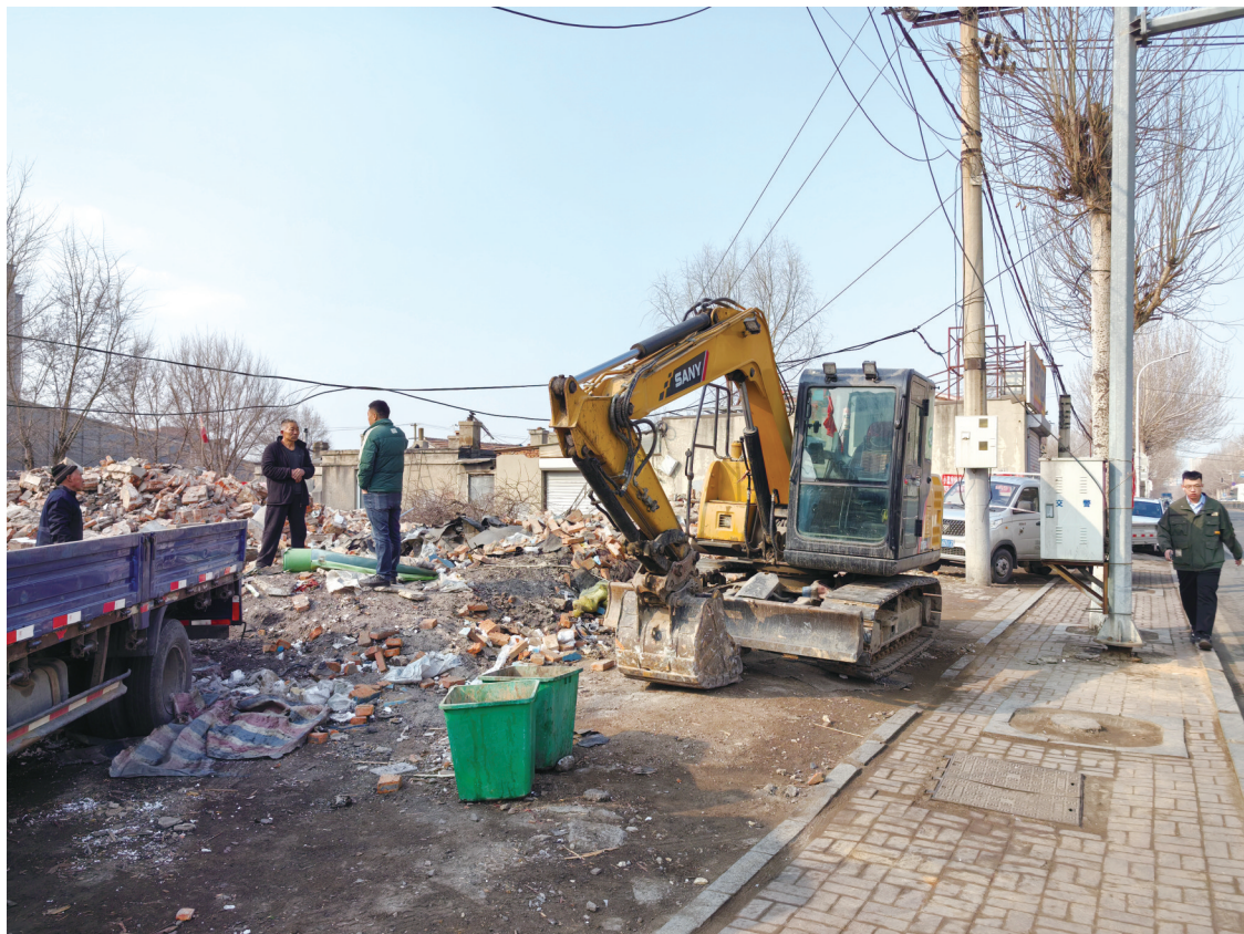
施工车辆和施工人员正在对现场进行处置 本组图片 城市晚报全媒体记者 陆续 摄
