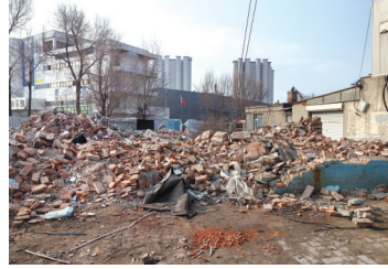
一处临街的商铺已经被拆除
