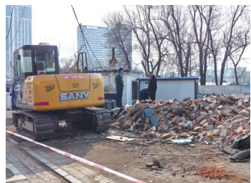
拆迁工作正在有序进行中
