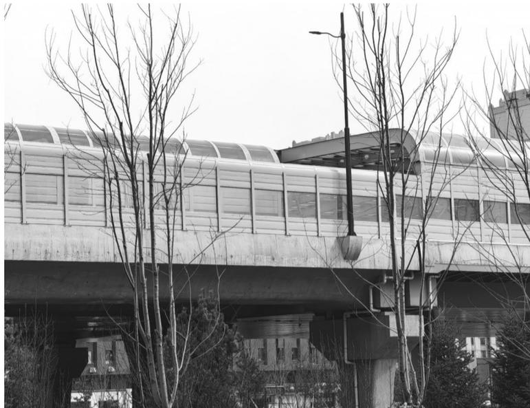
高架桥入口处没有安装全棚式声屏障 城市晚报全媒体记者 陆续 摄
