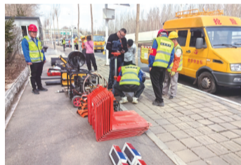
工人在有序进行排水管网疏通
