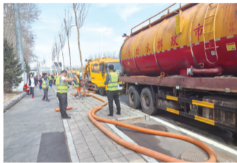
现场有大型排水疏通车
