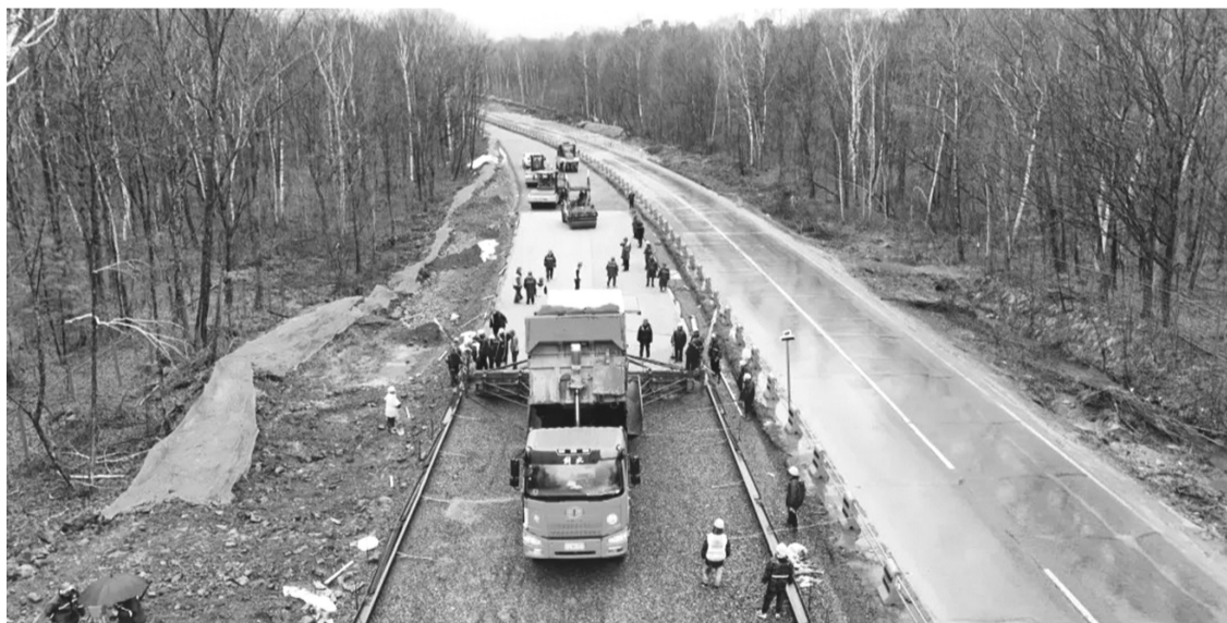
路面水稳结构层试验段作业 本组图片 省高建局供图
