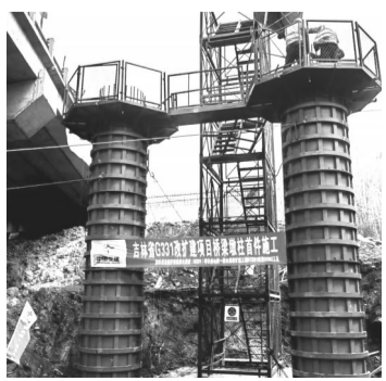
白河大桥墩柱首件完成浇注
